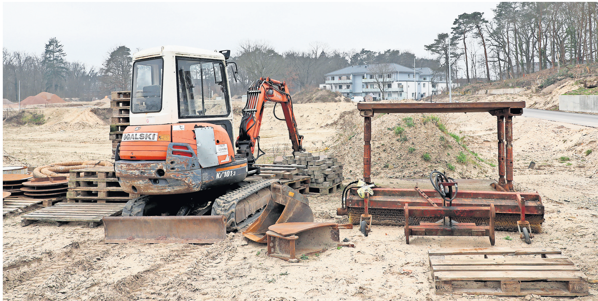
Jetzt geht's an den Hochbau: An der Feldstraße entstehen die Reihenhäuser, die zum Gesamtkonzept des 120-Millionen-Quartiers Hohe Düne gehören.
